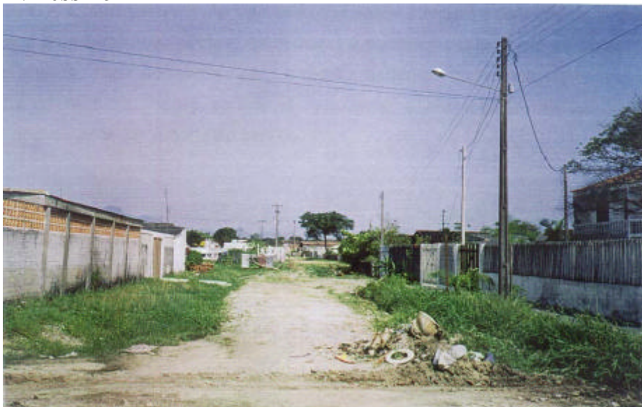
Foto 6.9: Ausência do sistema viário
