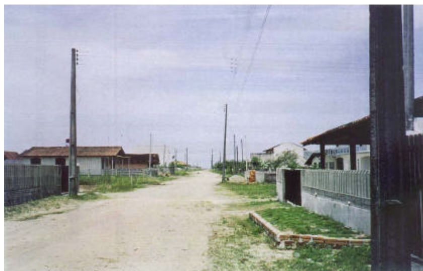
Foto 6.7: Traçado irregular da rede de energia elétrica
