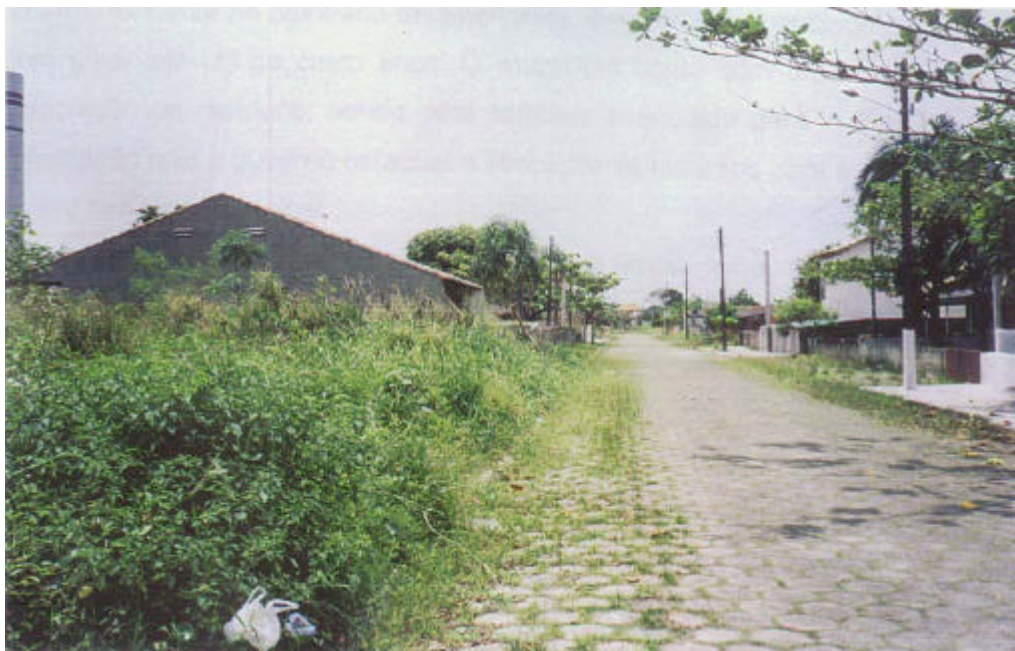
Foto 6.2: Precariedade no serviço de roçagem e capinação
