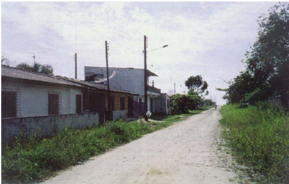
Foto 6.3: Precariedade no serviço de roçagem e capinação
