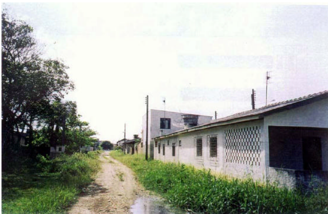
Foto 6.6: Traçado irregular da rede de energia elétrica
