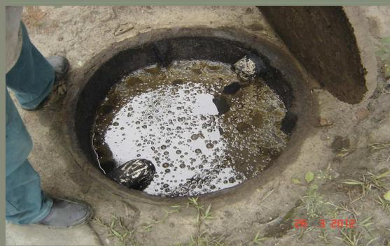
Infiltração de Combustível em Pista não revestida
