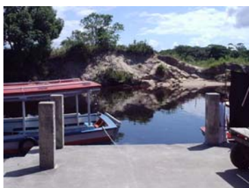
Erosão das margens
