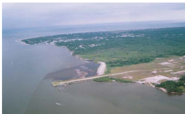
Vista aérea parcial da Unidade 01
