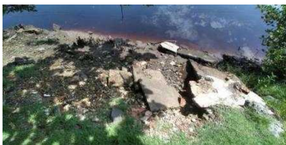
Figura 66: Área de depósito de entulho, lixo e/ou material construtivo (PT027 UTM: 22K 747087/ 7142782).
