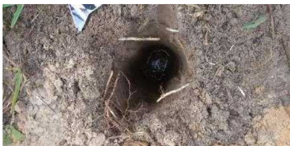
Figura 131: Poço teste finalizado devido a saturação hídrica (PT009 UTM: 22J 749422/ 7147038).
