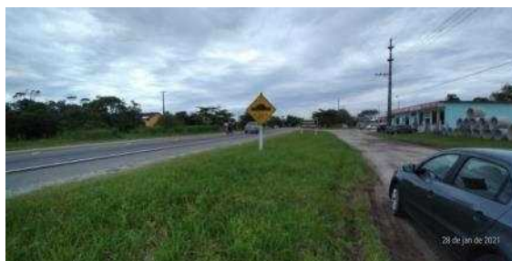
Figura 21: Via pavimentada (PR-412) nas proximidades do trecho 3. (UTM 22 J 749182/ 7147117).
