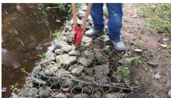
Figura 95: Local com proteção dos taludes com gabiões (PT061 22J 746864/ 7140555)
