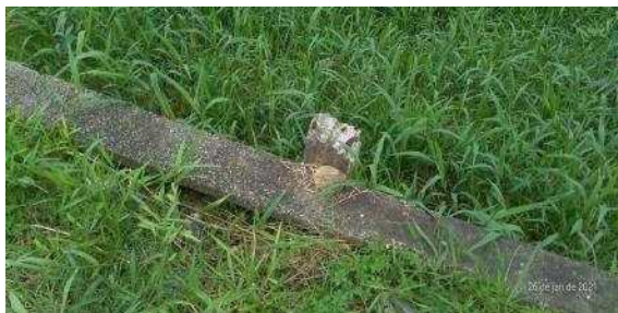
Figura 97: Material construtivo depositado nas margens do rio para firmar o talude (PT039 22J 745823/ 7140929).
