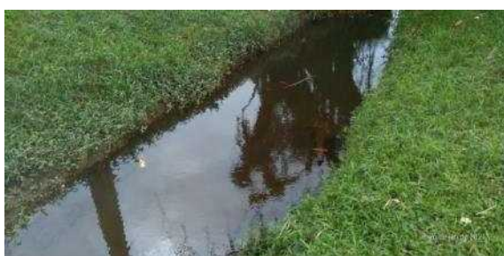
Figura 42: Canal de drenagem na Av. Paraná. (PT049 UTM 22J 746308/ 7140763)
