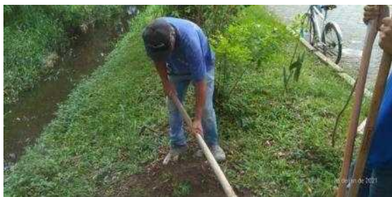
Figura 11: Limpeza superficial de aproximadamente 1 metro de diâmetro para início de perfuração (PT059 UTM: 22J 746773/7140597).
