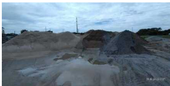
Figura 129: Área de depósito de material sedimentar, local já aterrado (PT003 22J 749141/ 7147160).
