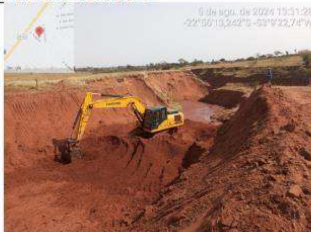
Foto 02 – Escavação do dissipador
