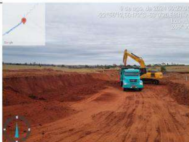
Foto 04 – Escavação do dissipador
