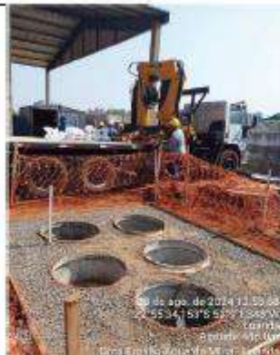
Foto 01 – Fossas do canteiro
