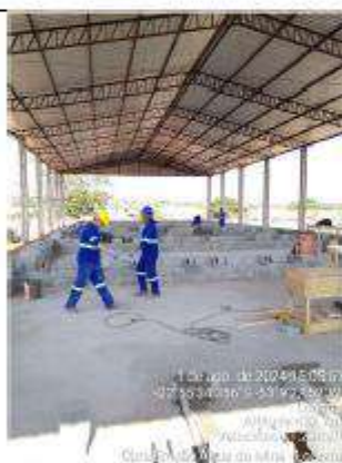
Foto 03 – Construção do canteiro
