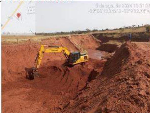
Foto 02 – Escavação do dissipador
