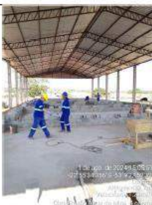
Foto 03 – Construção do canteiro
