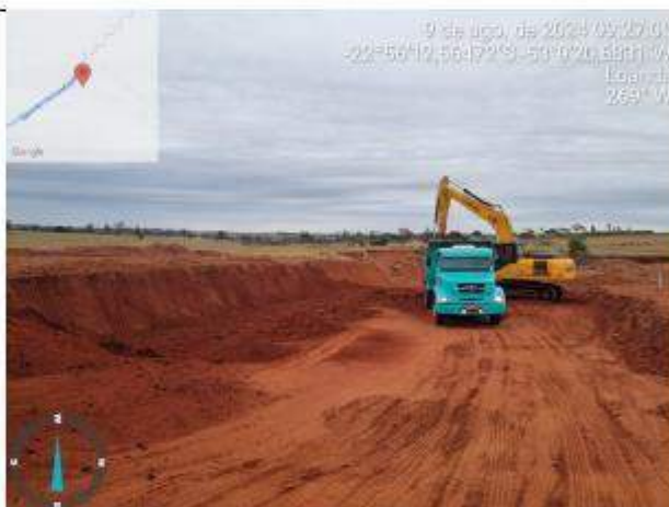
Foto 04 – Escavação do dissipador
