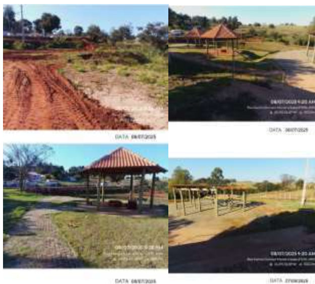
Imagens de acompanhamento da obra do Parque Urbano de Moreira Sales
