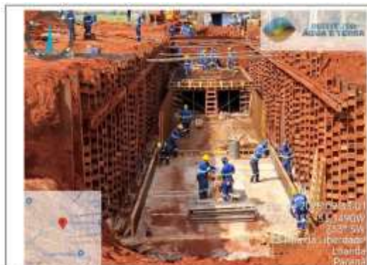
Foto 01 – Montagem forma e armação fundo e misula aduela est. 0+348 a est. 0+360
