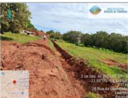
Foto 14 – Vala provisória para desvio de drenagem urbana
