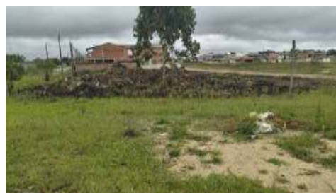
Foto 04 – Desmobilização lateral para continuidade da bacia CO 83/2022 – Bacia 01-02B
