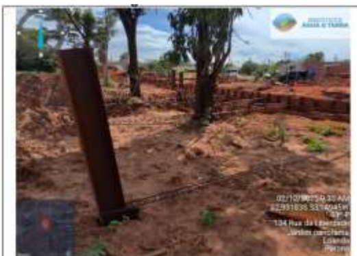
Foto 13 – Estaca de ancoragem de tirantes para suporte do escoramento da escavação
