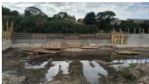
Foto 01 – Execução do dispositivo de entrada CO 78/2022 – Bacia 01-01
