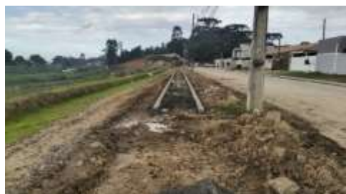
Foto 03 – Execução da pista de caminhada entorno bacia CO 78/2022 – Bacia 01-01
