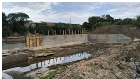
Foto 02 – Execução do dispositivo de entrada CO 78/2022 – Bacia 01-01
