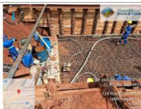
Foto 06 – Equipamento vibratório do concreto
