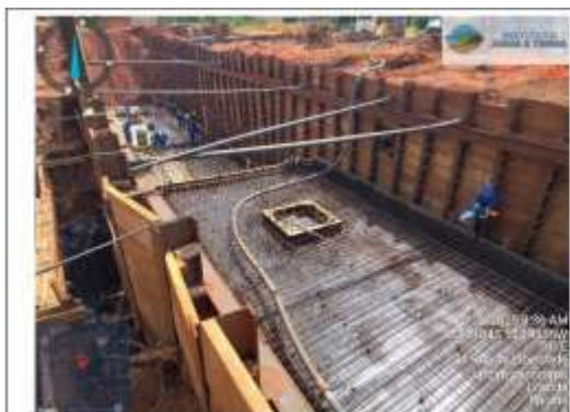
Foto 05 – Concretagem paredes misula e laje superior aduela est. 0+360 a est. 0+372
