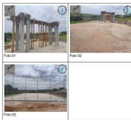
Imagens de acompanhamento da obra do Parque Urbano de Jaguapitã
